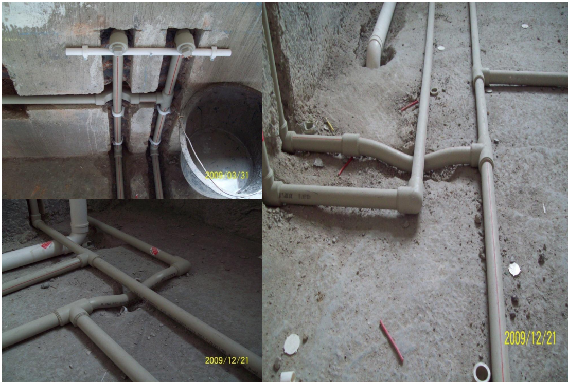
※热熔技术：接头处不易出现渗漏
