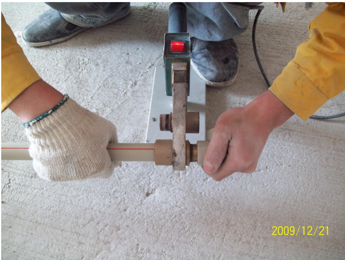
※热熔技术：接头处不易出现渗漏
