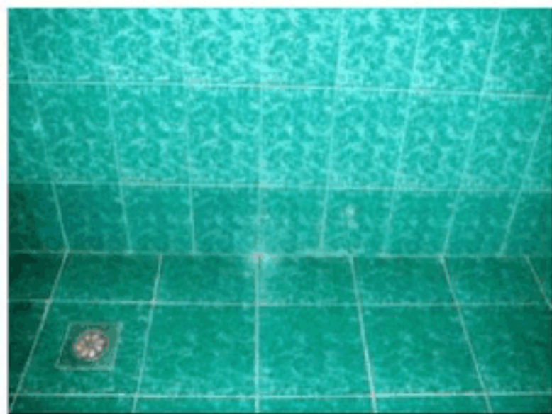
图 1.1-8 墙地面对缝实例图
