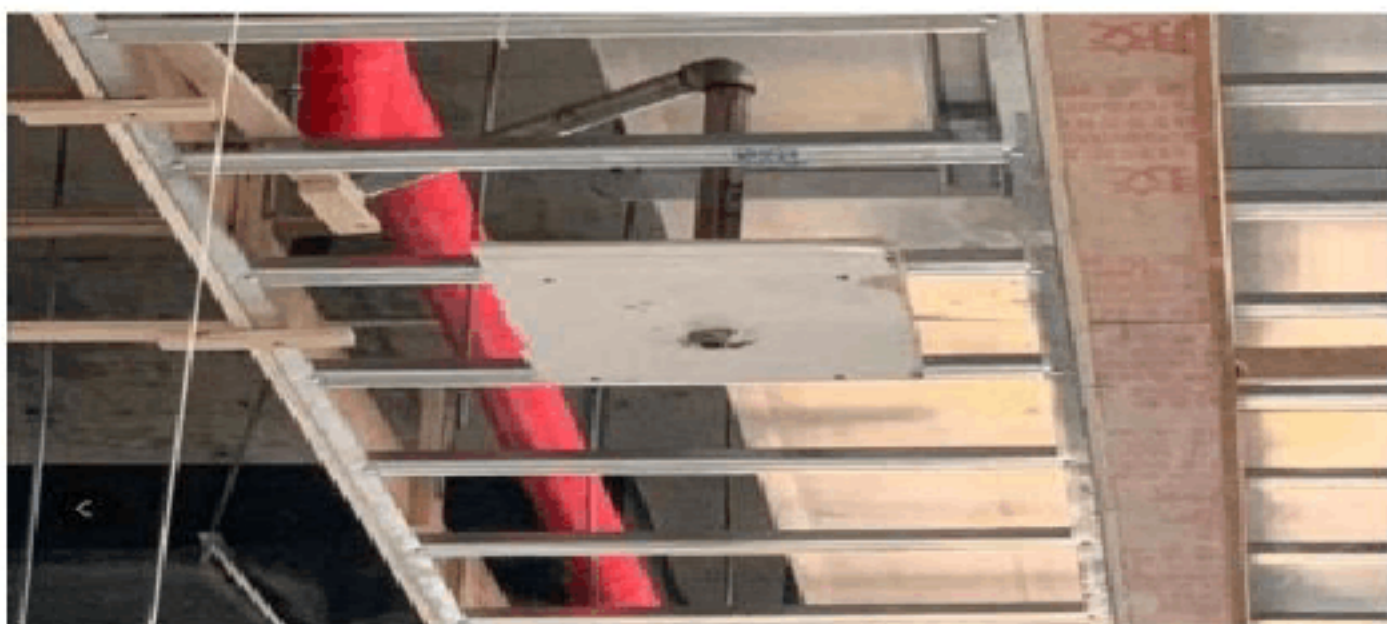
图 1.5-6 喷淋位置强制定位实例
