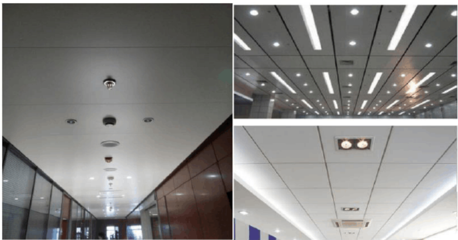
图 1.5-2 末端设备排布实例图
