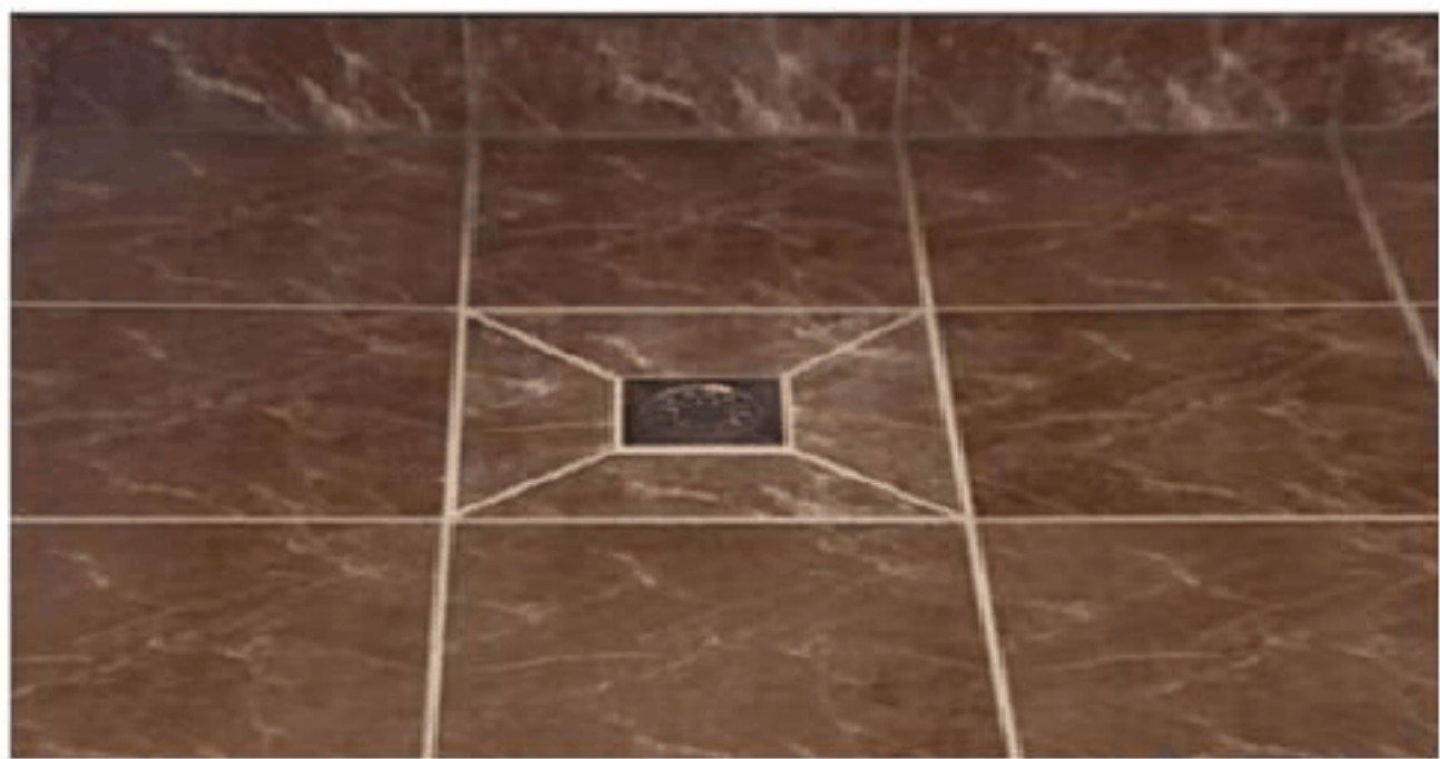
图 1.4-9 地漏处块材地面排版实例图
